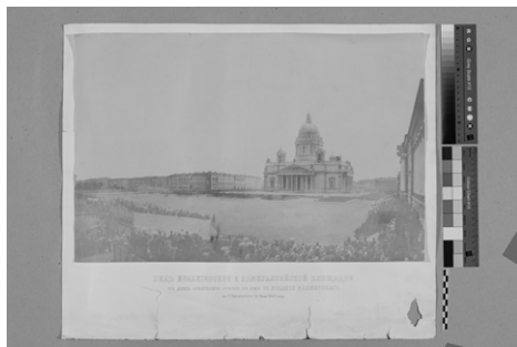
Рис. 1. Фотография в процессе реставрации
